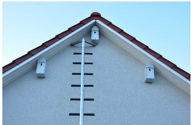
...je nach Fassade in verschiedenen Farben. (Foto: S.Hinrichs)
